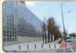
▲ 도로에 소리가 반사되는 성질을 이용해 방음벽을 설치한다.
